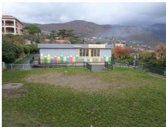
Figura 1.1 - Vista della facciata esposta Sud
