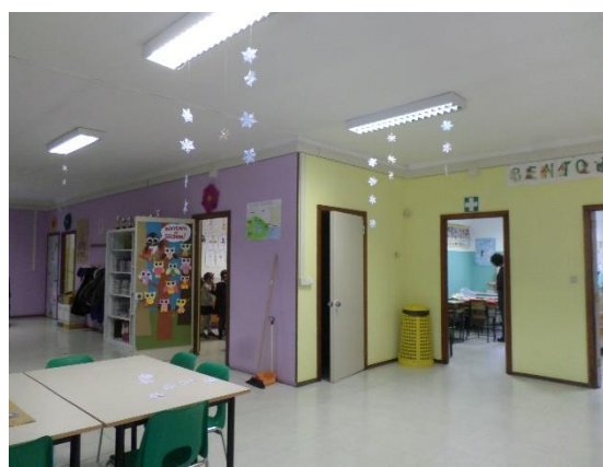
Figura 8.4 - Particolare dei corpi illuminanti attualmente installati
