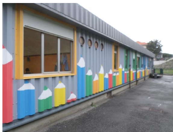
Figura 4.2 - Particolare della facciata est
